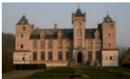
De provincie West-Vlaanderen werkt aan een afwegingskader voor kastelen en kasteeldomeinen. In het kasteel van Tillegem zijn diverse diensten van de provincie ondergebracht.
